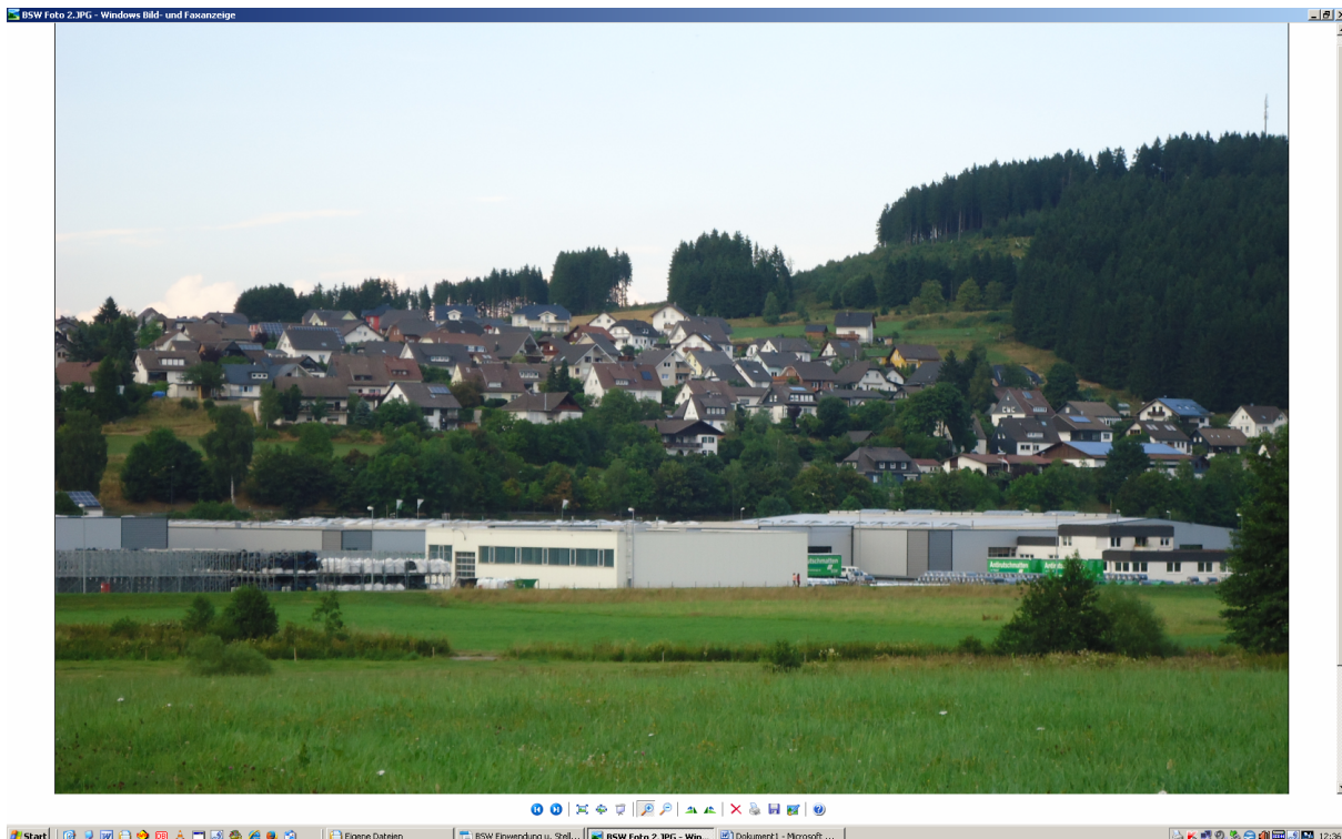
9. August 2013 von der Ederaue aus nach Norden in Richtung BBP Hinterstöpel – östl. Teil des Firmenareals mit Büro- und Wohn(!!!)-gebäude
